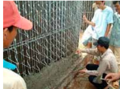
De bouw kan al plaatsvinden in de periode dat het mobiele ziekenhuis er nog staat.
