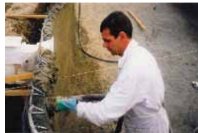
Met een speciale pomp wordt 'licht beton' in het raamwerk geïnjecteerd waardoor stevige buitenwanden, plafonds en daken ontstaan
