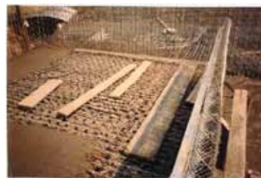
De vloeren worden gevormd door beton te gieten, bij voorkeur in meerdere lagen voor een goede warmte-isolatie.
